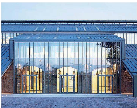
Il Tecnopolo realizzato nel Capannone 19 delle vecchie Officine Reggiane
